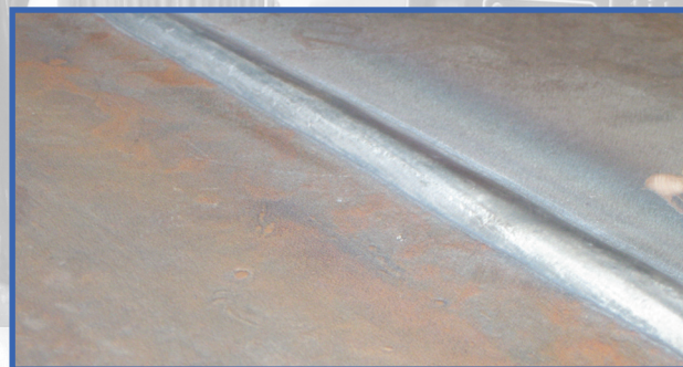
Рис.4 внешний вид стыкового шва
