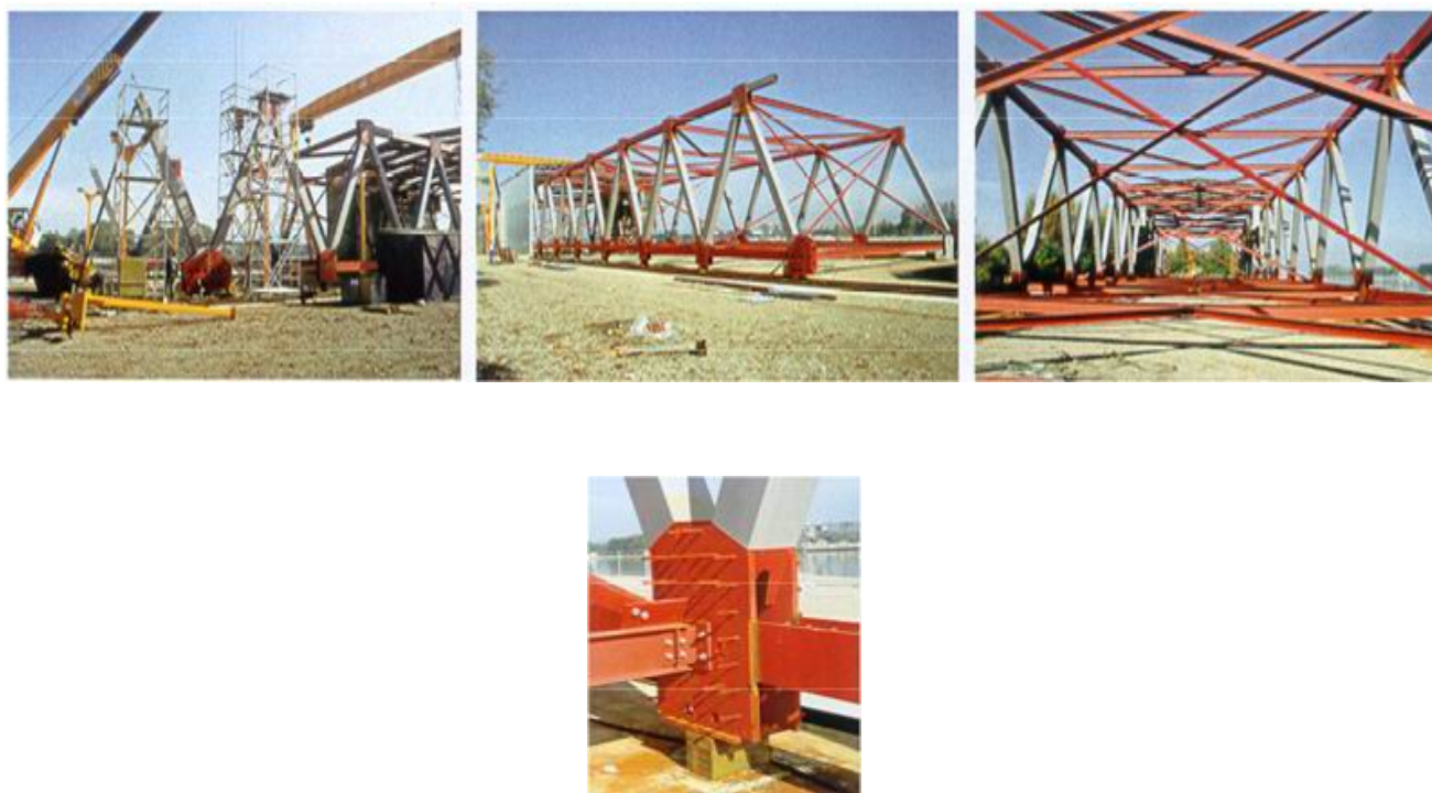
Рис.2 Сварные фермы моста “Dreirosenbrücke“ и сварные элементы креплений Сварка велась стандартной металлопорошковой проволокой МЕГАФИЛЛ 710М в полевых условиях.
